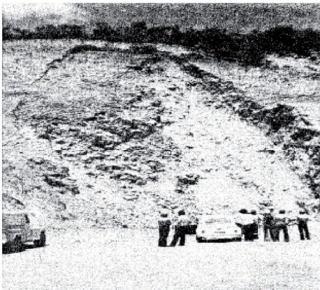
Figura 4.2 Instabilização de latitude, em maciço graníticognáissico alterado. Ferrovia do Aço, trecho Belo Horizonte-Jeceaba (MG) (Foto de A. Bartorelli, 1975)
