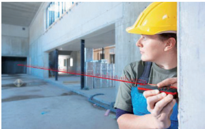
Medição interna com trena a laser
