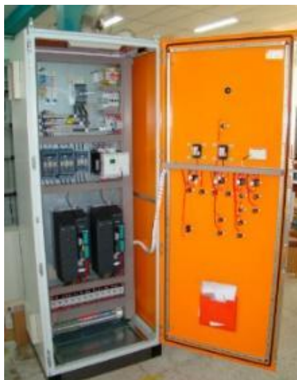
Figura 17: Imagem ilustrativa de Montagem de quadro elétrico trifásico.
