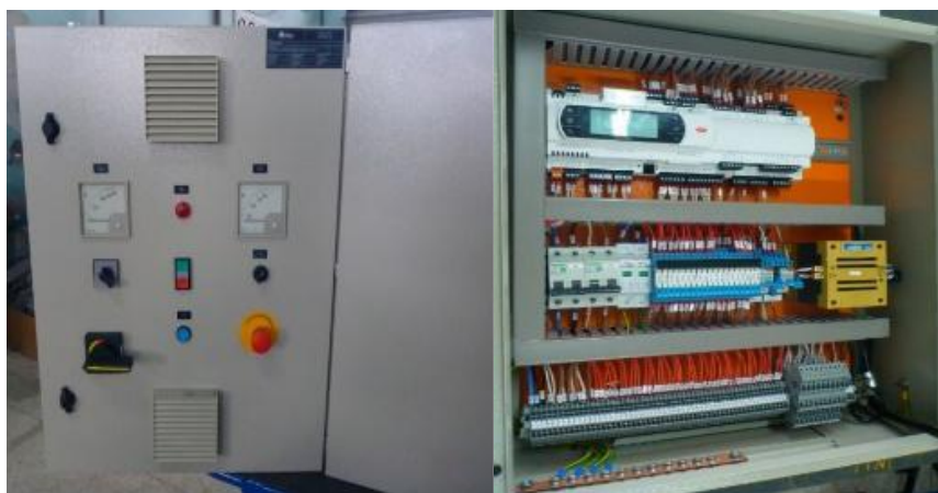
Figura 14: Imagens ilustrativas de Montagem de painel comando elétrico.
