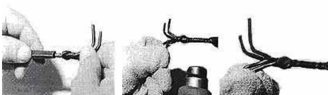
Figura: Isolação com isolante tubular termocontrátil
