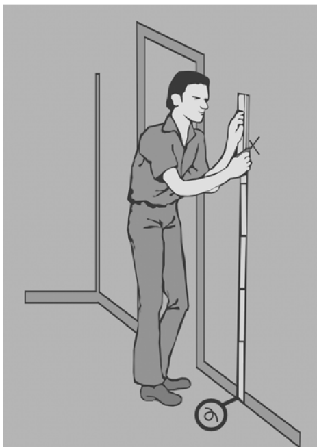
Fig. – Marcando a posição do interruptor
