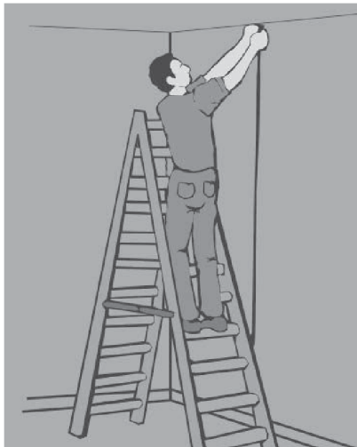
Fig. – Marcando o percurso da instalação na parede
