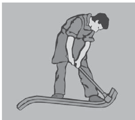
Fig. – Preparando a curvatura do eletroduto
