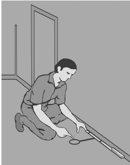
Fig. – Marcando no chão a posição do interruptor
