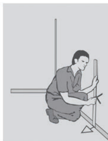
Fig. – Marcando a posição da tomada
