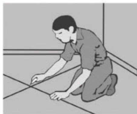
Fig. – Marcando no chão a posição da lâmpada
