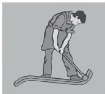
Fig. – Preparando a curvatura do eletroduto
