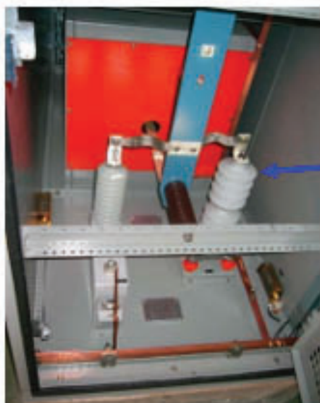
FIGURA – PÁRA-RAIO POLIMÉRICO
