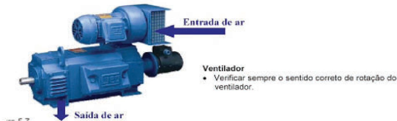
Figura 83: Sentido da ventilação.
