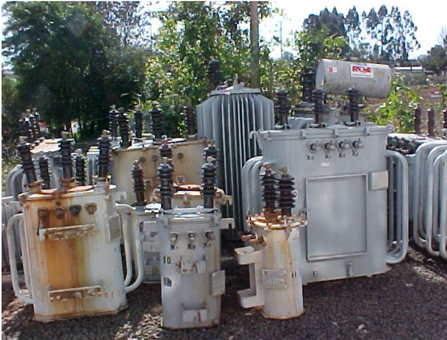
Na foto acima são vistos transformadores monofásicos e trifásicos avariado aguardando recondicionamento
