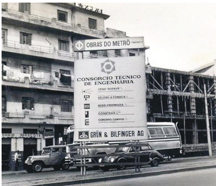
Figura 13: Construção do metrô em São Paulo.
