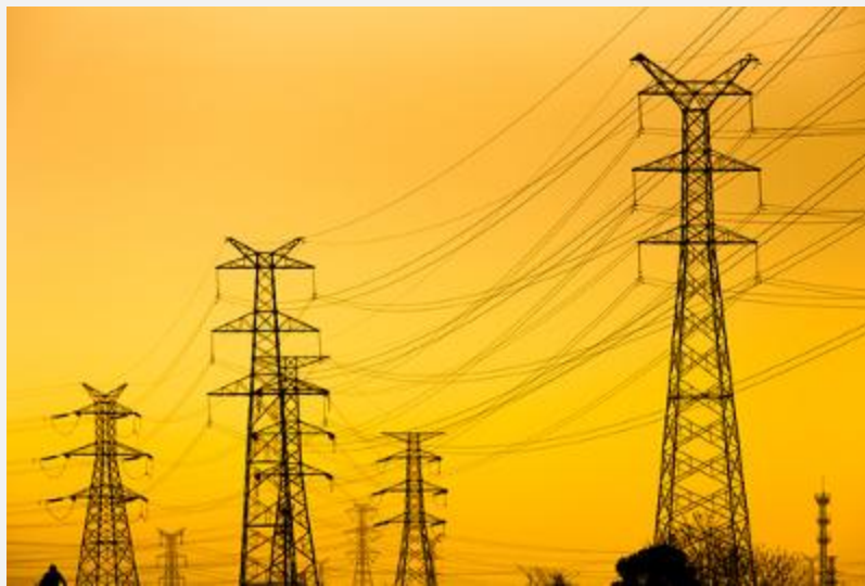
Figura 18: A eletricidade é transmitida pelas torres de transmissão.
