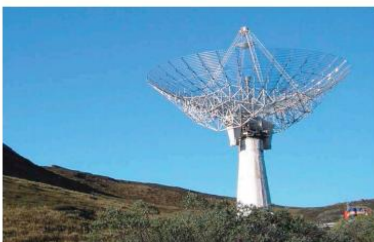
Figura 49: Antena cassegrain.
