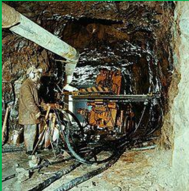
Figura 18: Uma perfuratriz sendo utilizada na perfuração da rocha.
