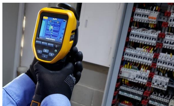
Figura 3: Termografia sendo realizada.
