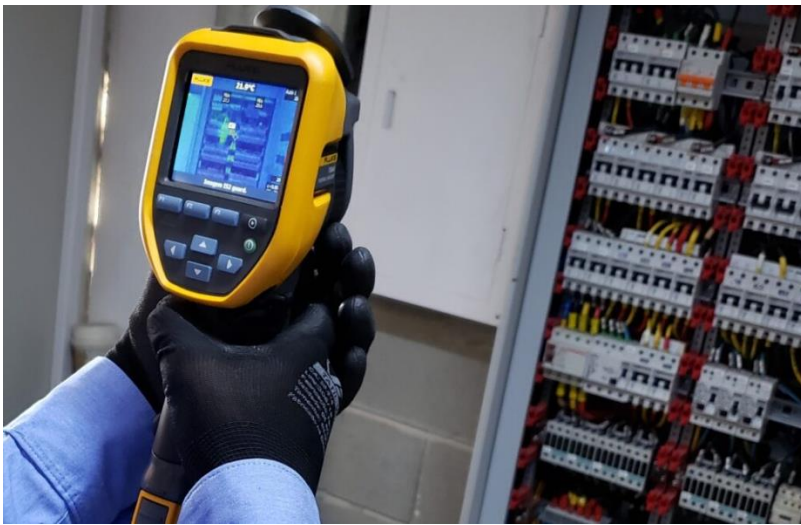
Figura 3: Termografia sendo realizada.
