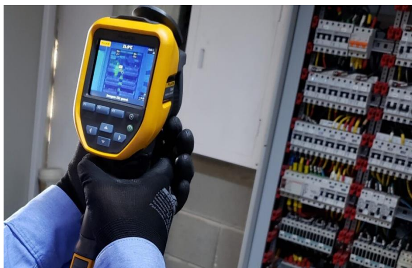
Figura 3: Termografia sendo realizada.
