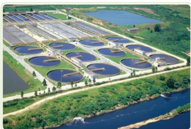
Figura 4: Estação de tratamento de água.
