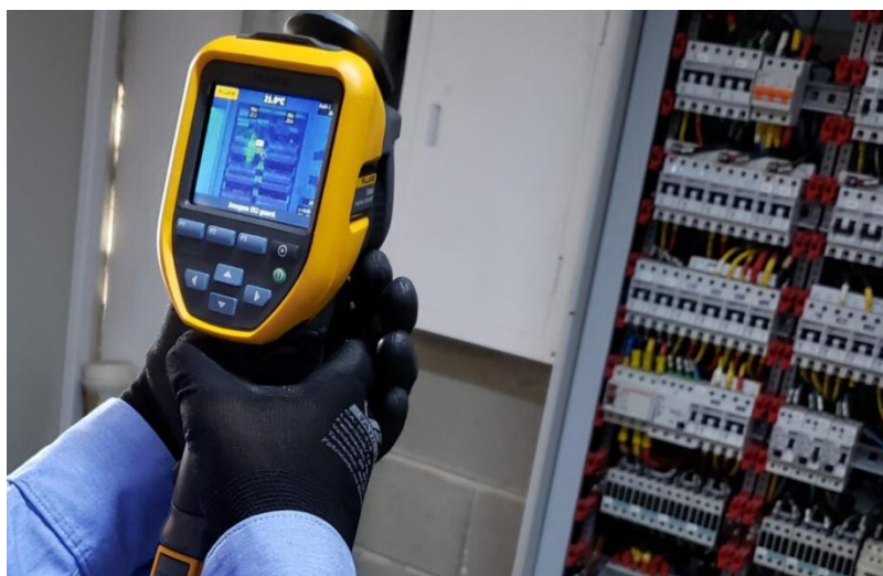
Figura 3: Termografia sendo realizada.
