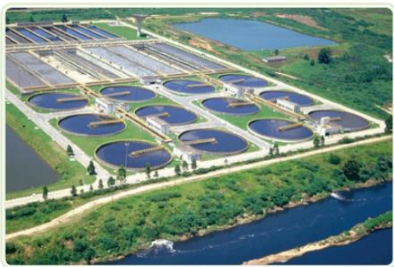
Figura 4: Estação de tratamento de água.
