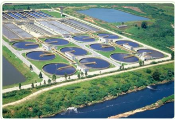
Figura 4: Estação de tratamento de água.
