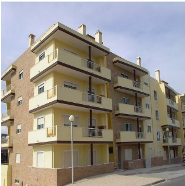
Fachada do prédio
