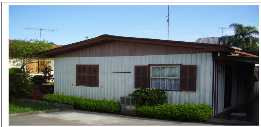
Fotografia 2 – Vista da Casa B - fundos
