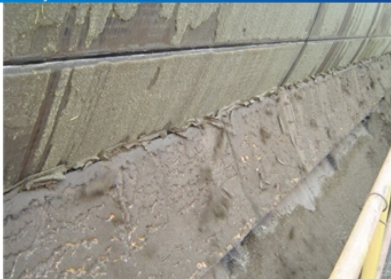
Figura 15.4.3 - Detalhe da retirada da Torta formada no Filtro Rotativo.
