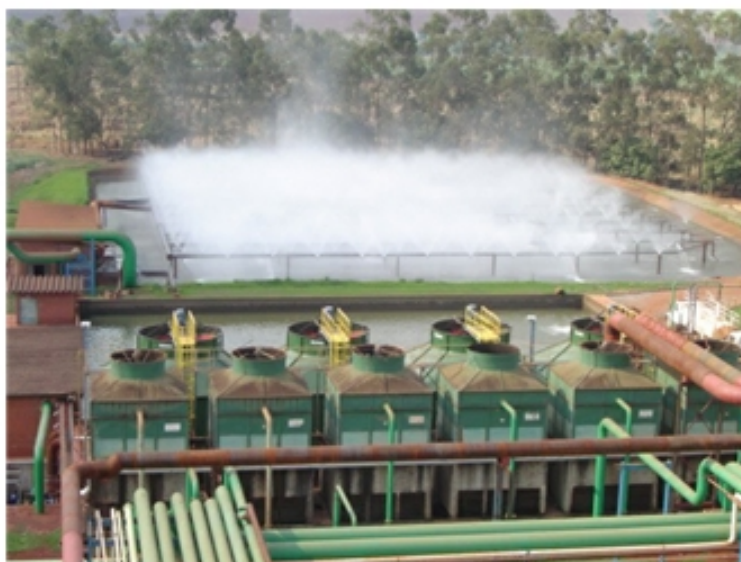
Figura 18.1.1 - Resfriamento de Águas Condensadas
