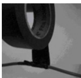
Aplicação das demais camadas de isolação
