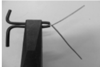
Iniciando a emenda tipo “rabo-de-rato”
