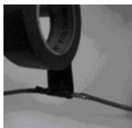
Aplicando a primeira camada da isolação
