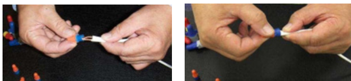
Encaixando as pontas torcidas dentro do conector.
